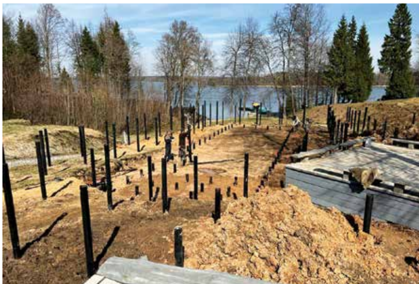
Свайное поле под бассейн, Московская область
