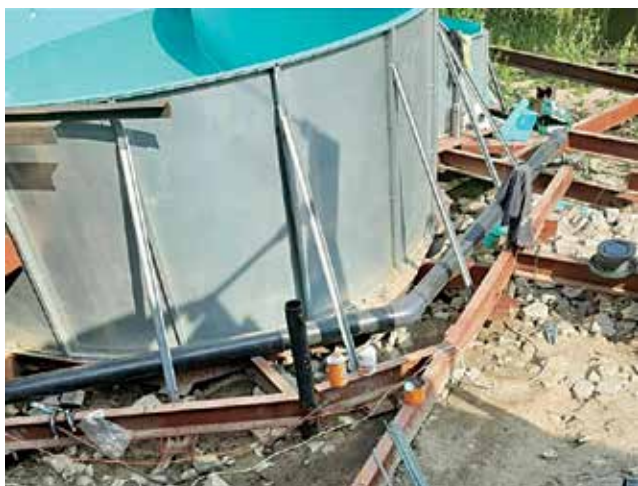
Бассейн монтируется на металло-каркас, Новосибирск
