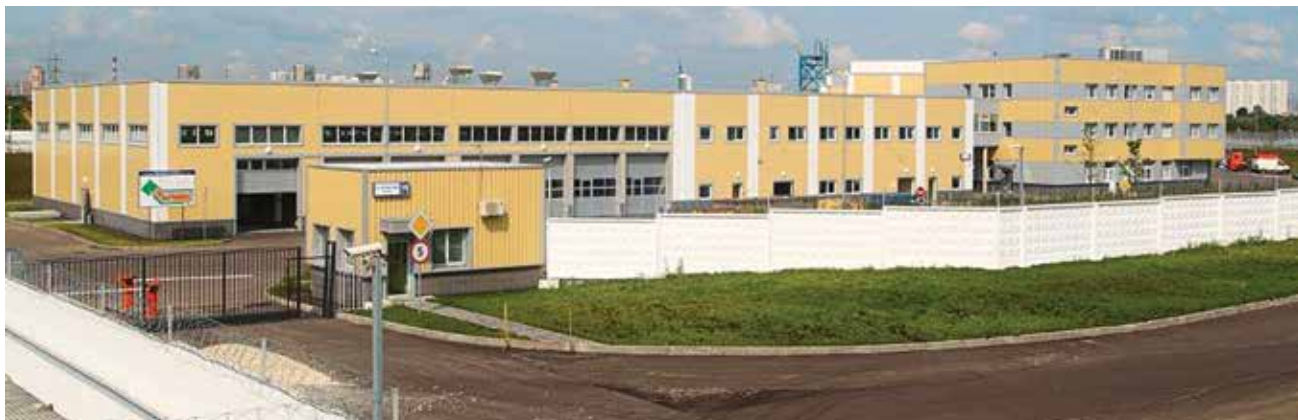
Завод «ВТЕ-Юго-Восток» (Москва)
